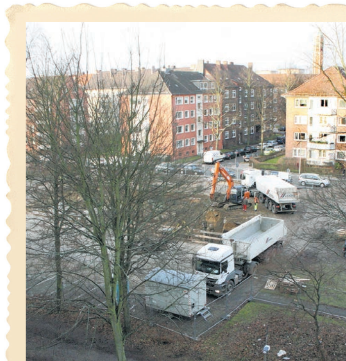
Blick auf die Baustelle Anfang 2015...
